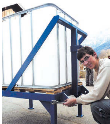
Michael Walder beim Verschrauben der Wasseranschlüsse (li), gemeinsam mit Lukas Holzer schneidet er mit der Bandsäge den Winkelstahl (ca. 5 m) für den Rahmen der Tränke zu (re)
