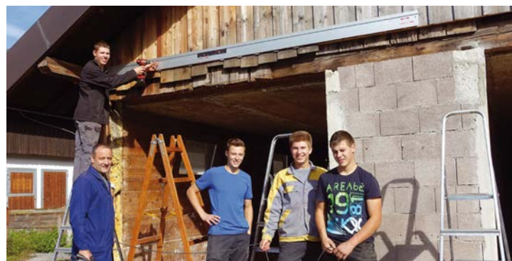
Anton Holzer mit Schülern des 3. Jahrganges beim Umbau des Schafstalles
