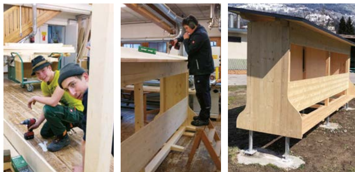
Links: Lukas Trojer und Niklas Zettl in der Holzwerkstatt Mitte: Tobias Unterguggenberger bei der Montage des Daches Rechts: Der fertige Bienenstand aufgebaut westlich der Metallwerkstatt
